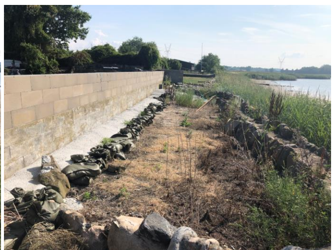
st. 610 nr. 16 Beton mur og gl. stensætning
