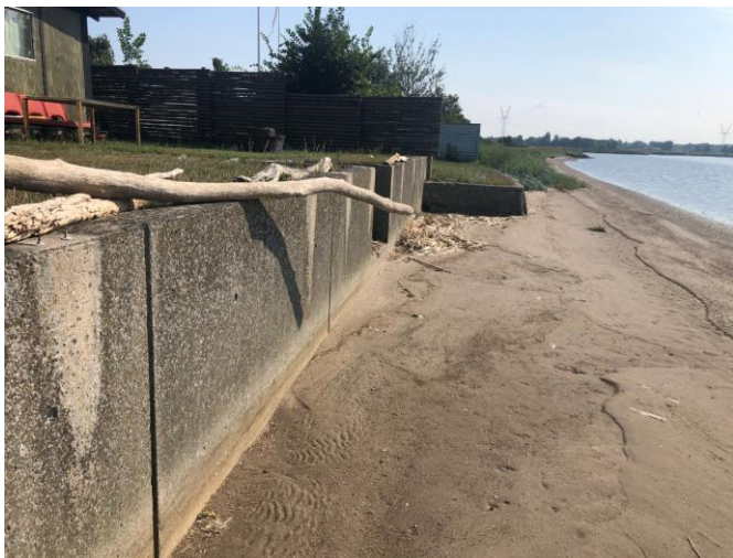
St. 850: eksisterende mur nr. 42 Ingen erosion
