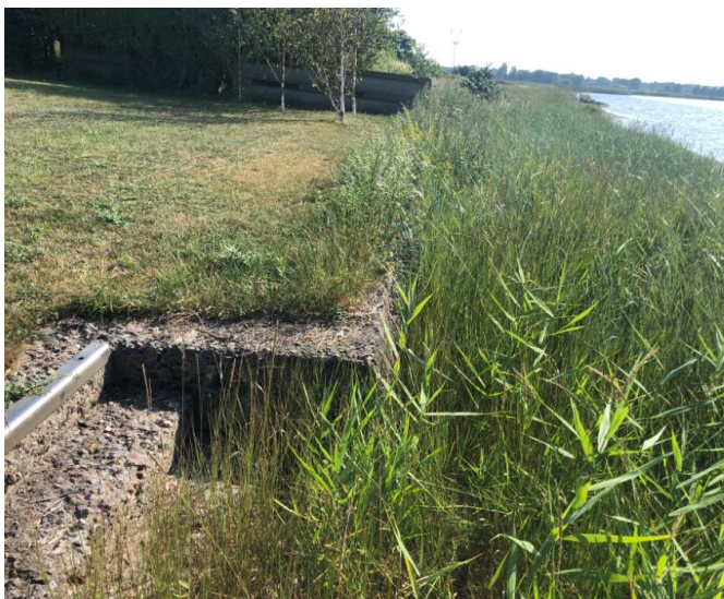
St. 805: eksisterende mur og trappe nr. 38 Inge erosion
