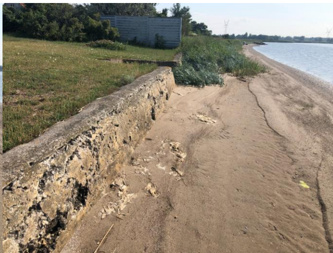
St. 820: eksisterende mur ved nr. 40 Ingen erosion
