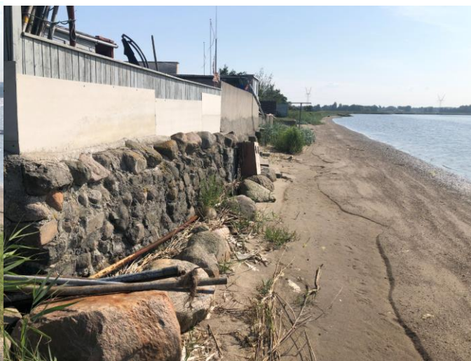
St. 875: nr. 44 eksisterende mur hvor fuldmur etableres Ingen erosion
