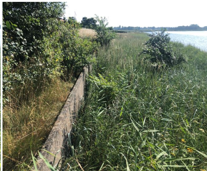
St. 780: eksisterende mur ved nr. 36 Ingen erosion
