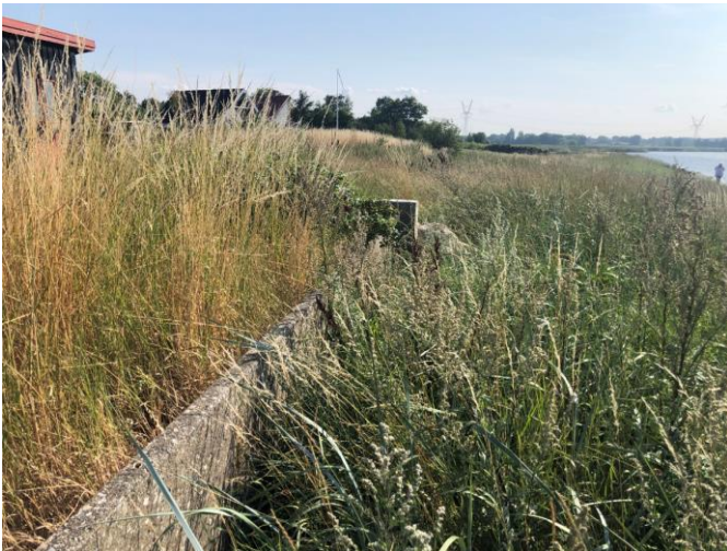
St. 770: v. hus nr. 36 eksisterende mur og overgang
