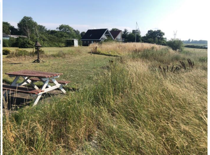
St. 760: Overgang mellem eksist. Mur og dige nr. 34
